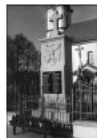
Renowacja pomnika i ogrodzenia Kościoła w Zebrzydowicach
