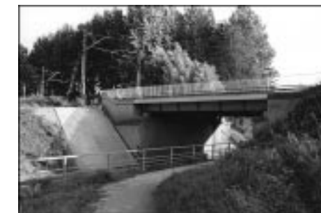
Zakończono remont wiaduktu PKP w Zebrzydowicach
