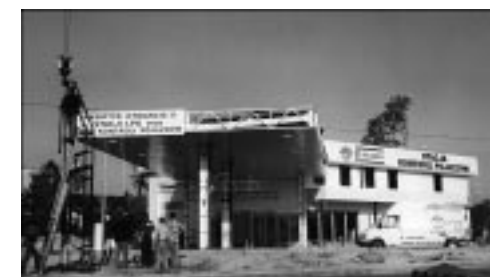
Firma BIELASZKA wybudowała w Kończycach Małych stację benzynową i kontroli pojazdów
