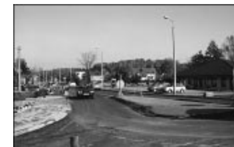
Rozpoczęto budowę ciągu pieszego przy ulicy Słowackiego w Zebrzydowicach
